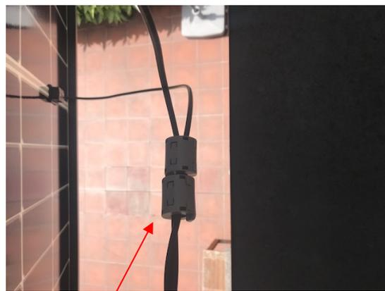
**Bild 7: Klappferrite auf den DC-Leitungen der Panels**
