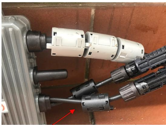
**Bild 6: Ferrite an allen Anschlüssen des Inverters**
