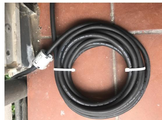
**Bild 9: Rest der 230VAC-Leitung aufwickeln**
